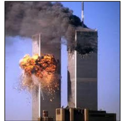
Momento da explosão da segunda torre do WTC, enquanto a primeira já estava em chamas.
